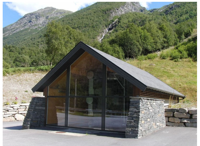
Tjøtaelva kraftverk, Hyen (kjelde: Småkraft AS)
